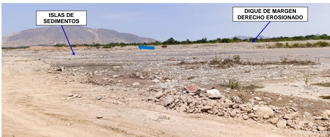
FIGURA N°04: RIO CHANCAY-HUARAL, CON LA MARGEN DERECHA AFECTADO POR EROSION EN PARTES SIN DIQUE Y EL CAUCE CON PRESENCIA DE ISLAS DE SEDIMENTOS EN DIFERENTES PARTES DESVIANDO EL CAUDAL HACIA AMBOS LADOS DEL CAUCE.
