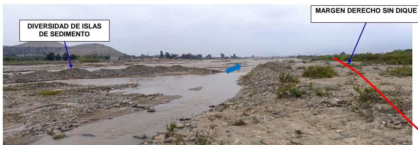
FIGURA N°02: CAUCE DEL RIO CHANCAY-HUARAL, PRESENTA ISLAS DE SEDIMENTOS Y MONTICULOS DE ARENA DESVIANDO EL CAUDAL HACIA LOS BORDOS CAUSANDO EROSION EN LOS DIQUES Y TRAMO EN LA MARGEN DERECHA SIN DIQUE
