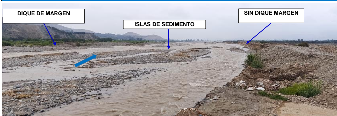
FIGURA N°01: RÍO CHANCAY-HUARAL, TRAMO CRITICO SECTOR LA HUACA MARGEN DERECHO EN PARTES SIN DIQUE, EN LA MARGEN IZQUIERDA EROSIONADO Y PRESENCIA DE ISLAS DE SEDIMENTOS EN EL CAUCE.
